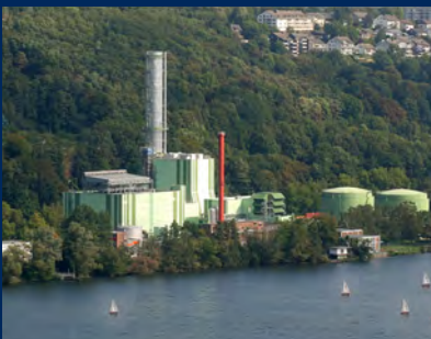
Gas-Kraftwerk Herdecke, Deutschland
