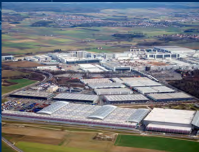
Güterverkehrszentrum Ingolstadt, Deutschland
