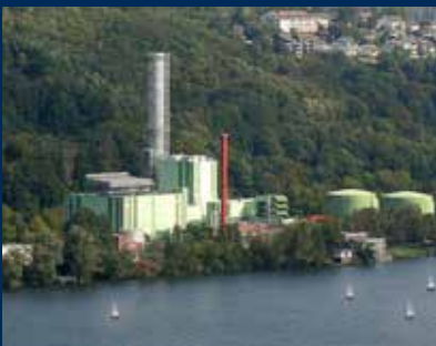
Gas-Kraftwerk Herdecke, Deutschland
