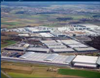
Güterverkehrszentrum Ingolstadt, Deutschland
